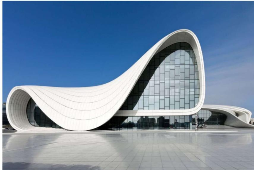
Il Centro Heydar Aliyev è costituito principalmente da due sistemi collaboranti: una struttura in cemento combinata con un sistema di strutture spaziali. Al fine di ottenere spazi di grandi dimensioni privi di colonne che permettano al visitatore di sperimentare la fluidità degli interni, gli elementi strutturali verticali vengono assorbiti dal sistema di involucro e facciata continua.
